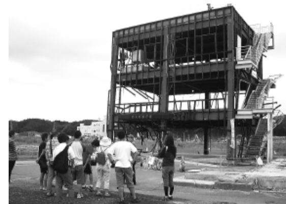
南三陸町防災対策庁舎跡
